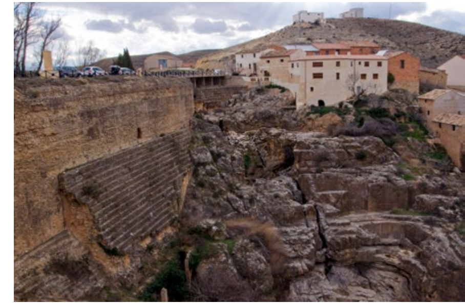
Almonacid de la Cuba, presa romana. ▲
